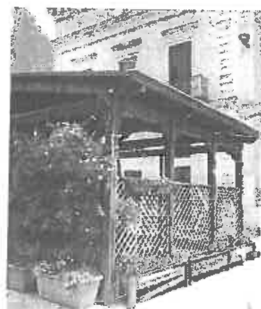
Tettoia (lato sud ovest)
